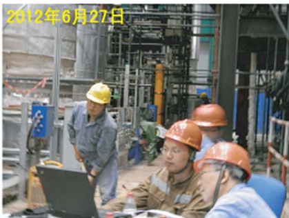
红沿河核电基础第二次试验
