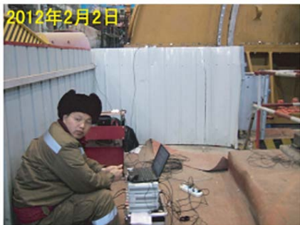
红沿河核电基础第一次试验
