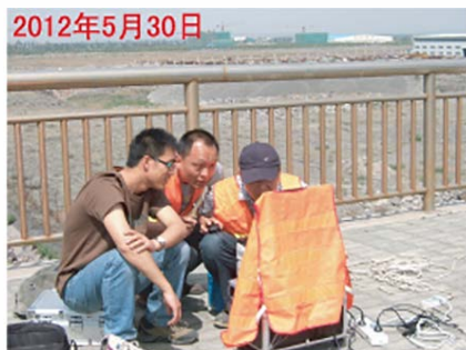
乌鲁木齐桥梁安全检测
